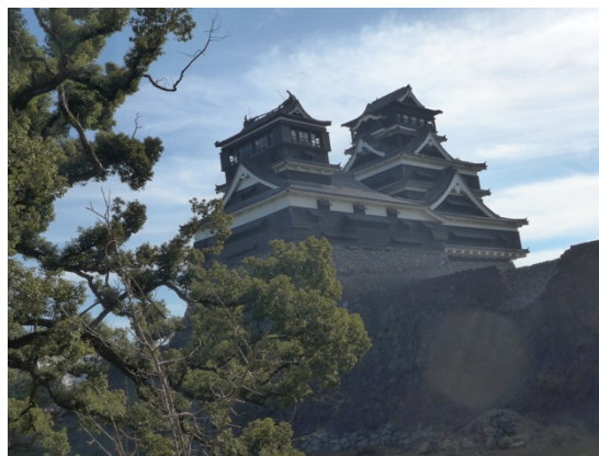
屋根や城壁が崩れた熊本城
