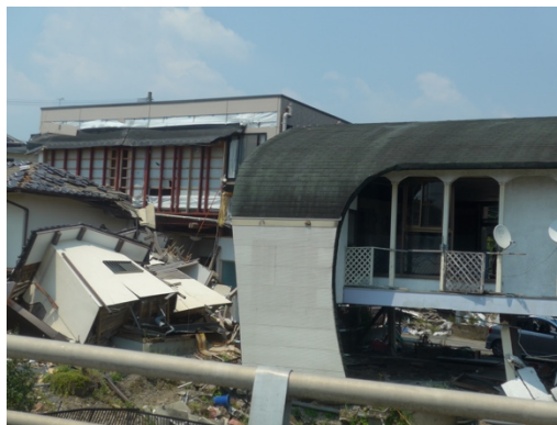
益城町の壊れた建物
