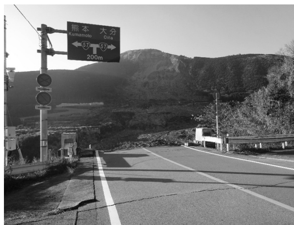
崩落した阿蘇大橋付近
