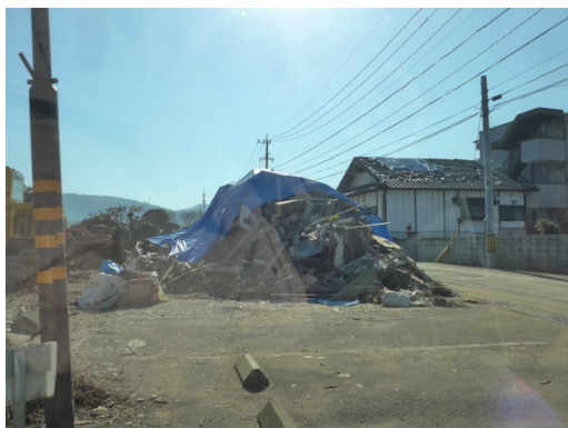
倒壊家屋の撤去が進む益城町
