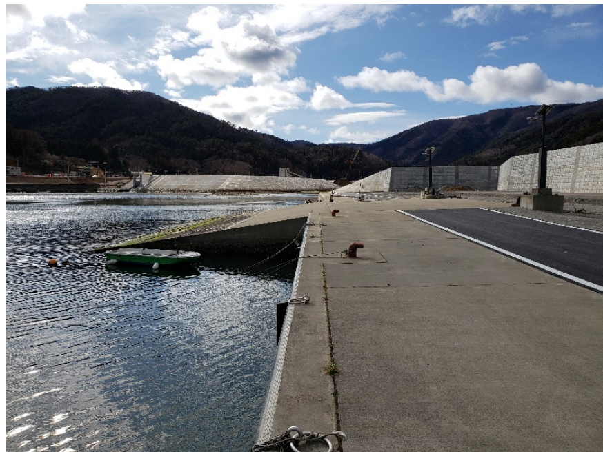
図5 雄勝湾を囲む防潮堤
