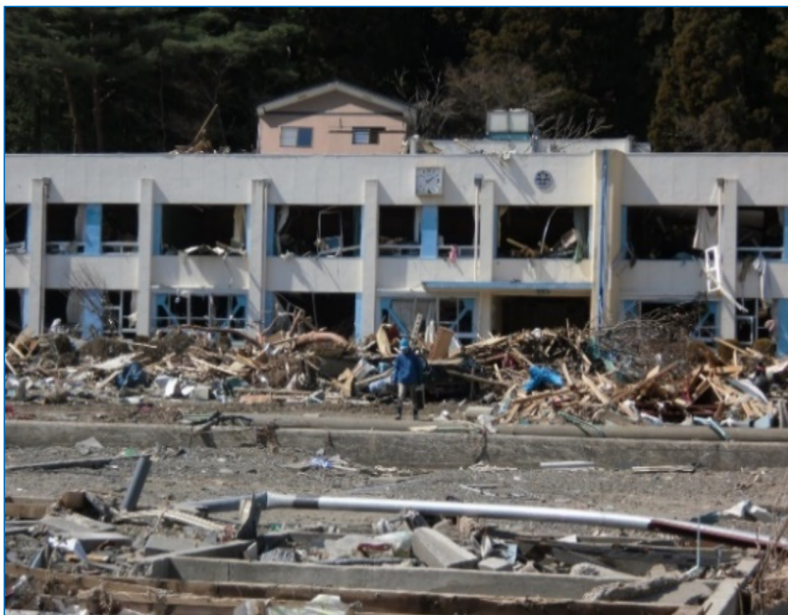
被災した雄勝小学校校舎（2011年3月）
