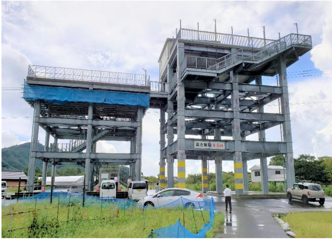
四万十町興津地区の海岸付近に建てられた避難タワー「おきつ2号」
