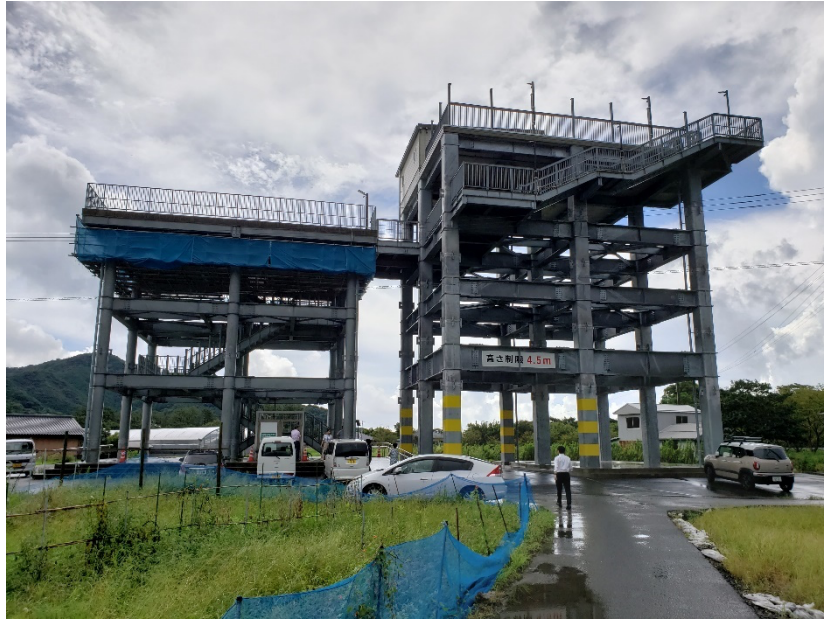
高知県四万十町興津地区の津波避難タワー
